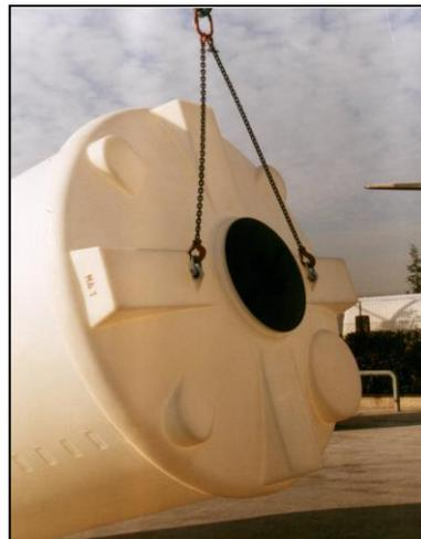
Nel caso infine in cui il serbatoio sia molto alto, è possibile utilizzare una gru imbracandolo sui fianchi con una fascia tessile oppure inserendo nella bocca di carico un travetto di legno opportunamente protetto alle estremità.
